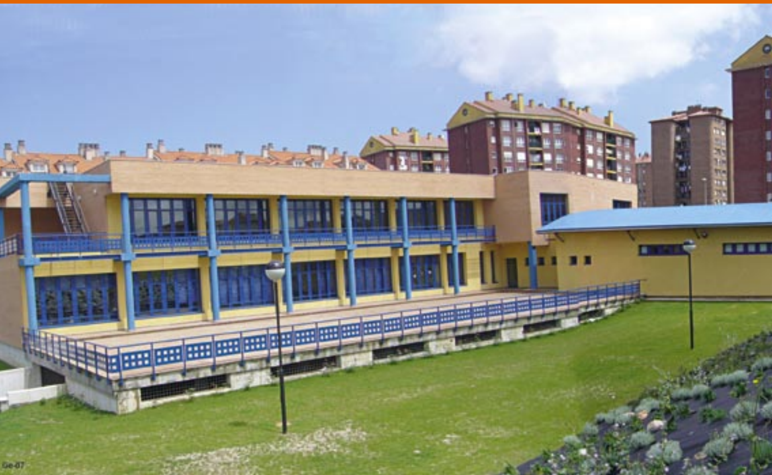
Vista posterior o trasera del nuevo edificio.
