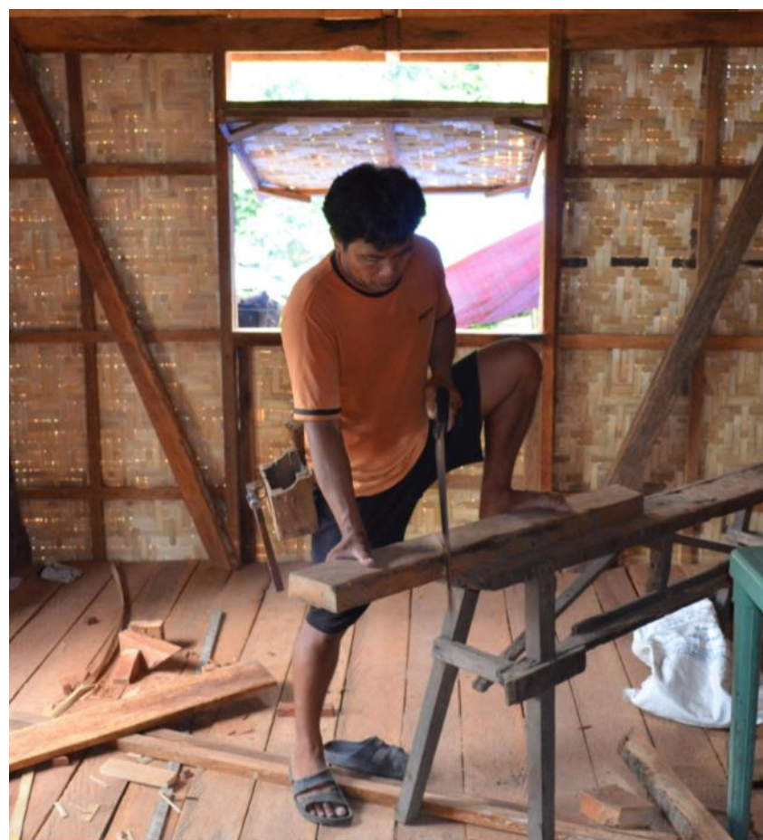
Un carpintero trabaja en la construcción de una vivienda en Tolosa.
