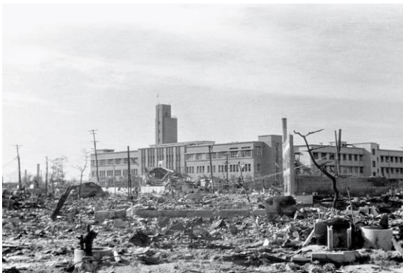
El hospital de la Cruz Roja Japonesa en Hiroshima sobrevivió a la bomba atómica, pero sufrió graves daños y prácticamente dejó de funcionar.
